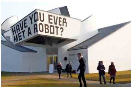
„Haben Sie schon mal einen Roboter getroffen?“, fragt das Vitra Design Museum. Achim Menges schon: Der „Elytra Filament Pavillon“ wurde mit Algorithmen entworfen und mit Roboterhilfe produziert.
